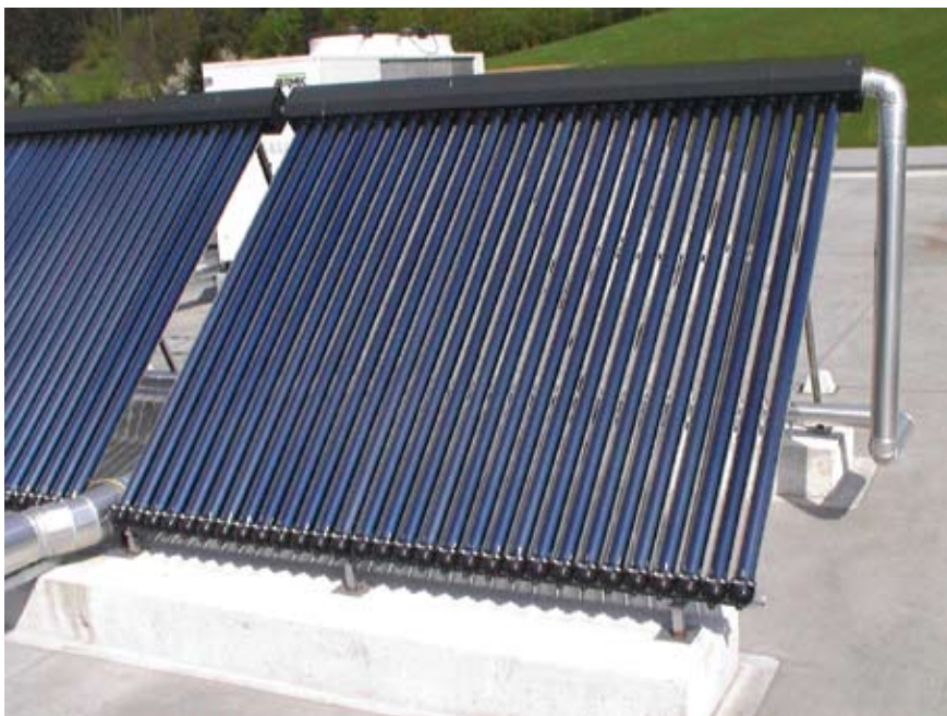
Slika 14: Primer sončnih kolektorjev za ogrevanje sanitarne vode
