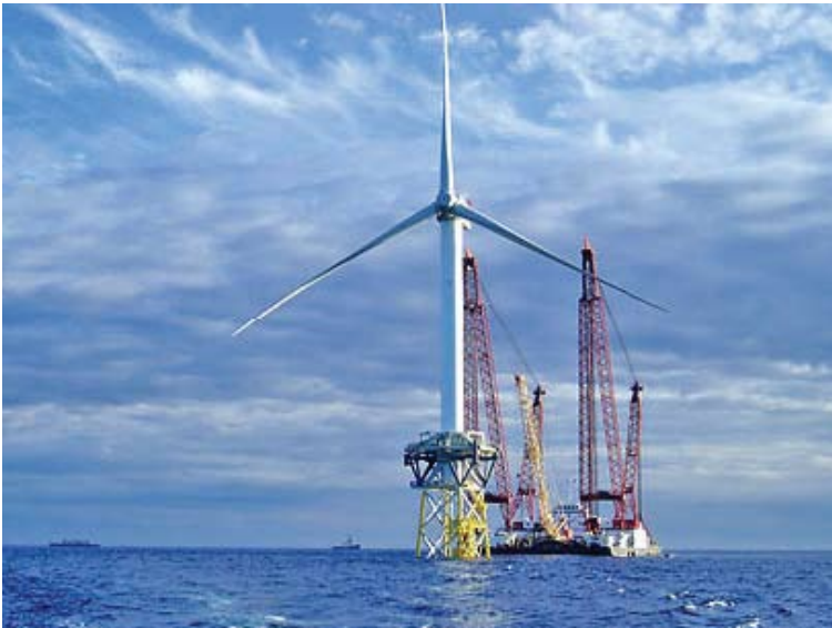
Slika 18: Gradnja vetrnice na morju
